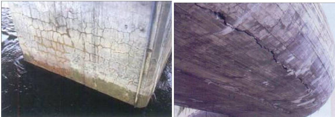
Fig.1-Fissurations dues à des alcali-réactions dans le béton d'une pile de pont immergé (à gauche) et dans le tablier d'un pont autoroutier (à droite).
